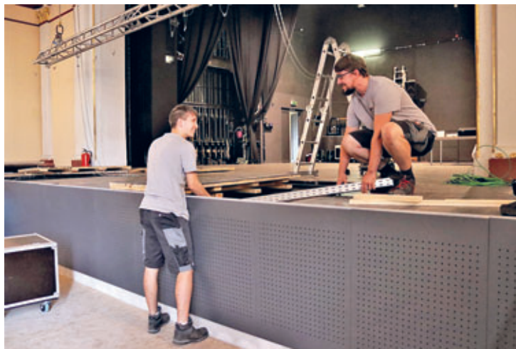
Jonas Wetzstein (l.) und Chris Walther beim Verlegen der Kabelleitungen.
