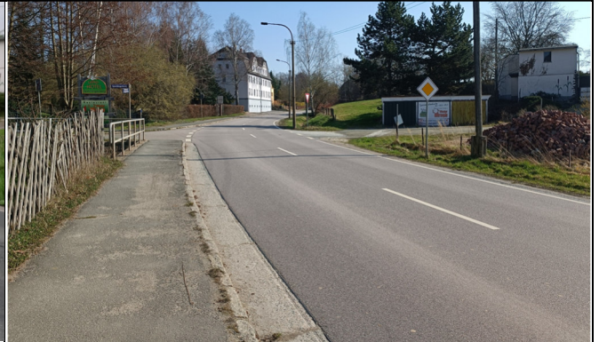
Fahrbahnzustand 2024 nach Sanierung
