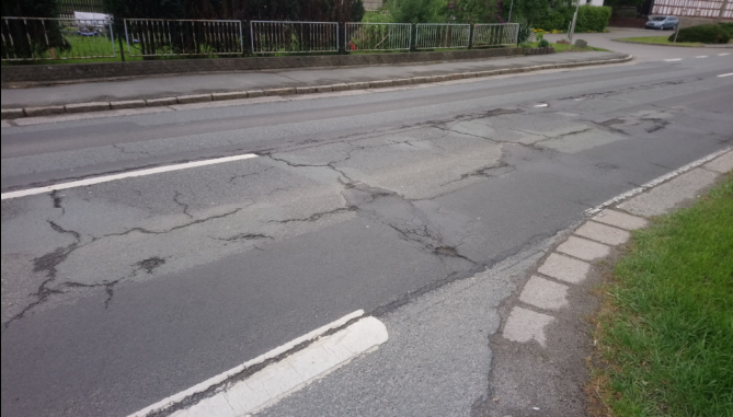
Fahrbahnzustand vor Gablenzer Hauptstraße Nr. 18a, Stand 2018, Unstetigkeiten mit Pegelüberhöhungen bei Überfahrten, insbesondere durch LKW
