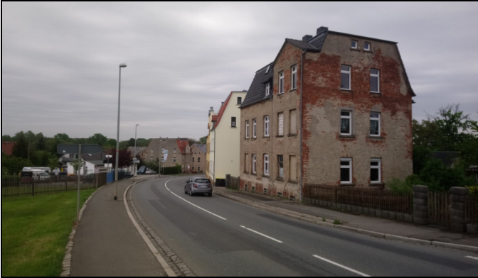
S 289, nach Einmündung Lauenhainer Weg aus Richtung Westen
